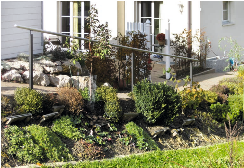
Handlauf aus Edelstahl mit verzinkten und beschichteten Stahlpfosten
