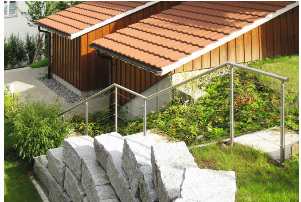
Handlauf aus Edelstahl mit Rundrohrpfosten in Neigung versetzt, zusätzlich mit Drahtseilen aus Edelstahl für mehr Sicherheit
