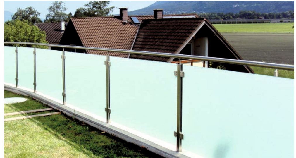
Geländer aus mattem Verbundsicherheitsglas mit Pfosten, Handlauf und Glashaltern aus Edelstahl
