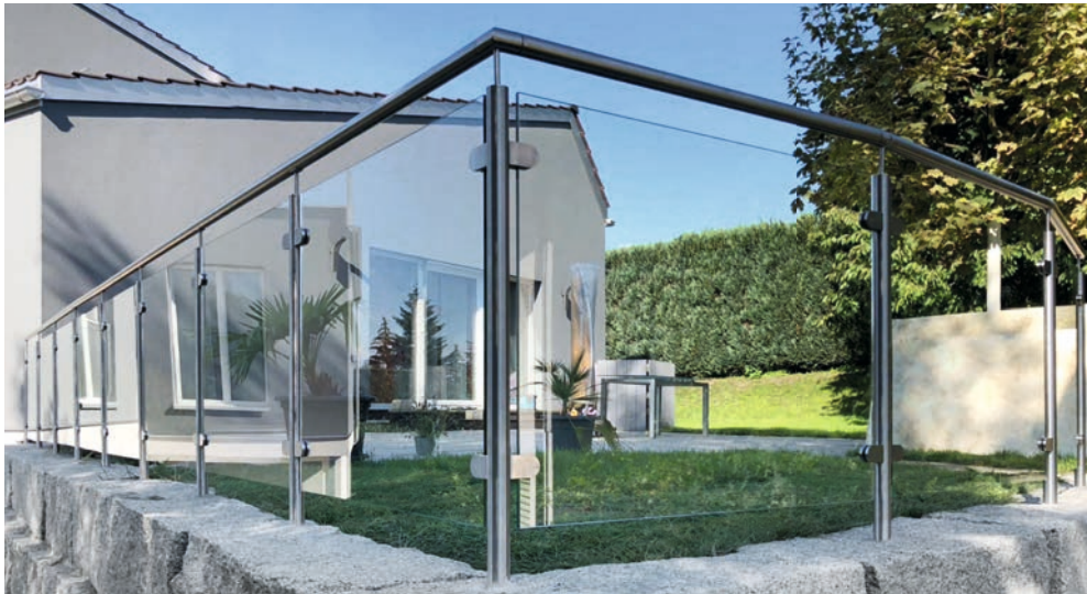
Geländer aus klarem Verbundsicherheitsglas mit Pfosten, Handlauf und Glashaltern aus Edelstahl
