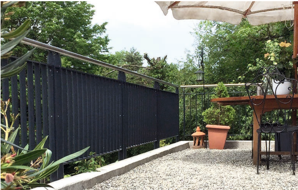
Staketengeländer Typ 4 aus Stahl, verzinkt und beschichtet, mit Handlauf aus Edelstahl
